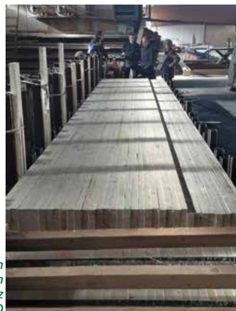
Fabrication d'une poutre en lamellé-collé chez COLLADELLO
