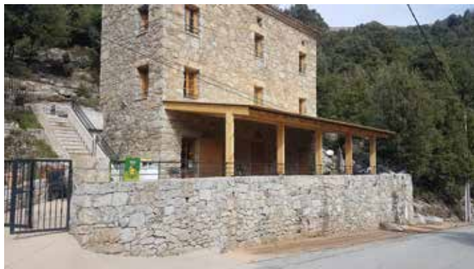
Nouveau préau de gîtes à Cristinacce en pin laricio
