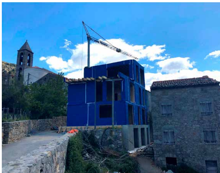
Construction en Pin lariciu sur la commune de Cristinacce
